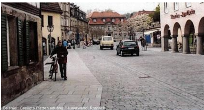
Beispiel: Gesägte Platten entlang Hauswand, Kronach
